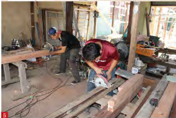
4 使える梁を活かして、新しい木材と繋ぎ合わせます。このような修復が大工の技術です 5 柱の切込みをする、出穂さん(後方の堤さんも一緒に切込みをしています)
