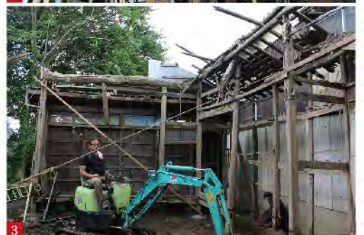
2 3 原形が殆ど残っていない町家を復元していきます
