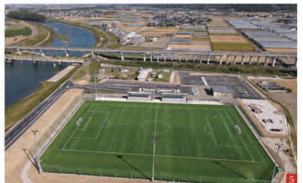
5 昨年10月に完成した新球技場とスケートボード場 その上を九州新幹線が走ります
